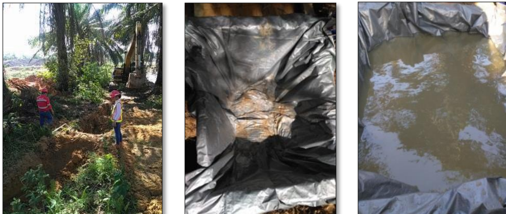
Gambar 3 Pembuatan Bak Buatan
