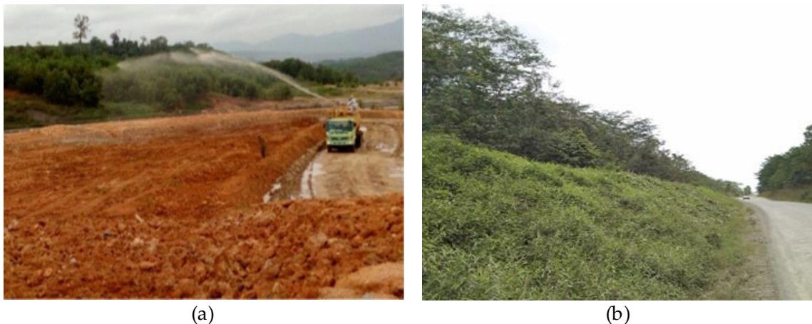
Gambar 1. Kegiatan Hydroseeding Pada Lahan yang Telah Selesai Dilapisi Tanah Pucuk (a); Hasil Hydroseeding Di Sepanjang Lereng Jalan Angkutan Menggunakan LCC (b)
