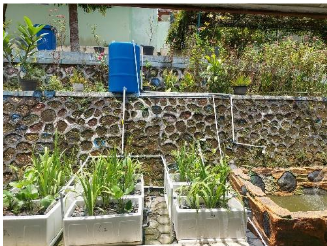
Gambar 2 Horizontal Subsurface Flow Constructed Wetland dengan tanaman hias Iris ( Iris Pseudoacorus ) dan Melati Air ( Echinodorus palifolius )
